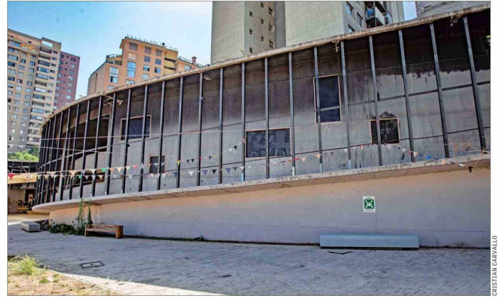
DETERIORO. — Aunque el edificio no sufrió daños estructurales con los incendios, sus paredes siguen cubiertas por hollín y sus columnas lucen desnudas por el impacto de las llamas.
