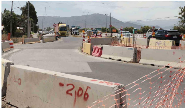
Nuevamente en stand-by se encuentran los trabajos de ampliación de Carretera el Cobre.
