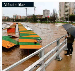
Viña del Mar Serios destrozos tuvieron los puestos de una tradicional feria hortofrutícola a raíz de la crecida del estero Marga-Marga, arrastrados por el cauce y sumergidos hasta los techos.
