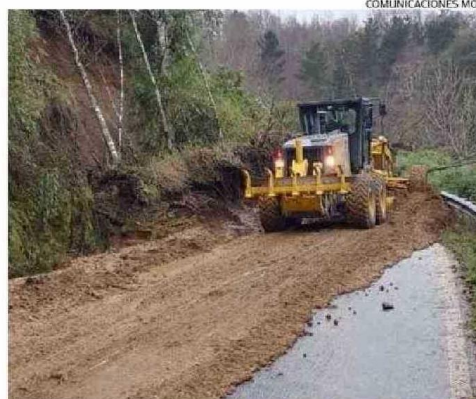
VIALIDAD TRABAJÓ EN DESLIZAMIENTO DE TIERRA EN LANCO.
