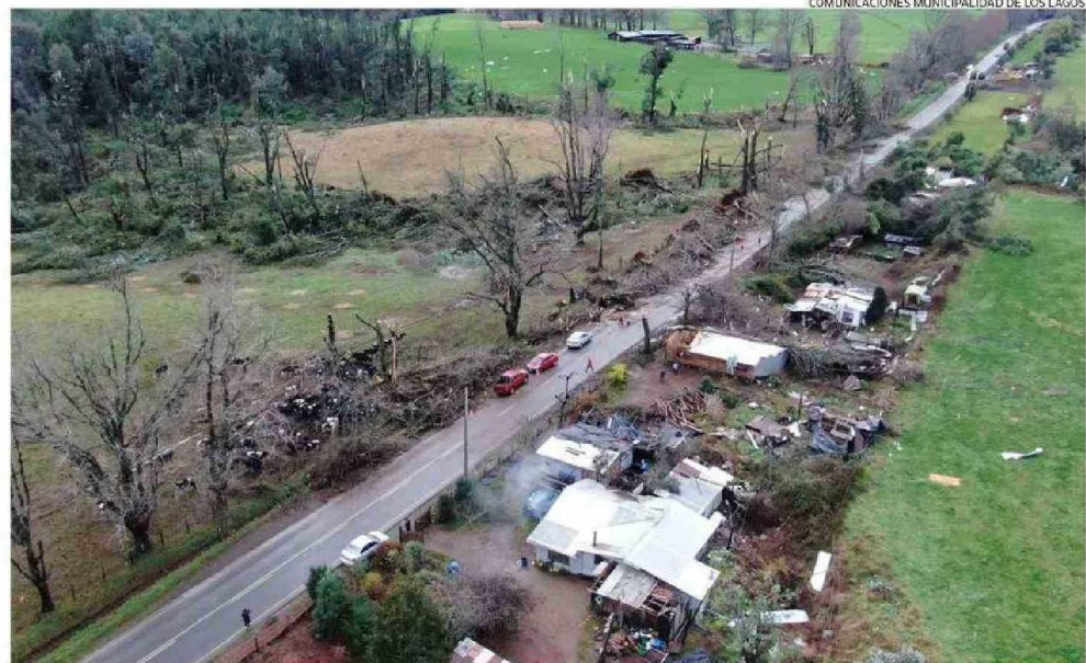
LOS VIENTOS DE ALTA INTENSIDAD, CON CARACTERÍSTICAS DE TORNADO, AFECTARON VIVIENDAS EN LANCO Y TAMBIÉN EN LA COMUNA DE LOS LAGOS.
