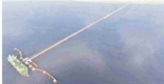
Imagen virtual de la infraestructura que permitirá transferir amoníaco en Tierra del Fuego.
