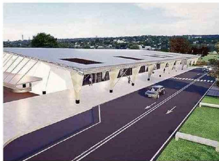
NUEVA TERMINAL INCLUIRÁ ELEMENTOS PATRIMONIALES DE RAPA NUI
