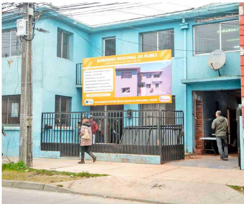
La estructura requiere remodelaciones internas dado que corresponde a una casa que data del año 1952.
