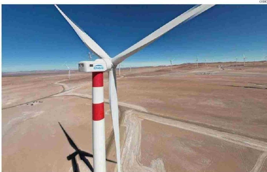
LOS 57 AEROGENERADORES APORTARÁN 342 MW DE ENERGÍA VERDE AL SISTEMA ELÉCTRICO NACIONAL.
