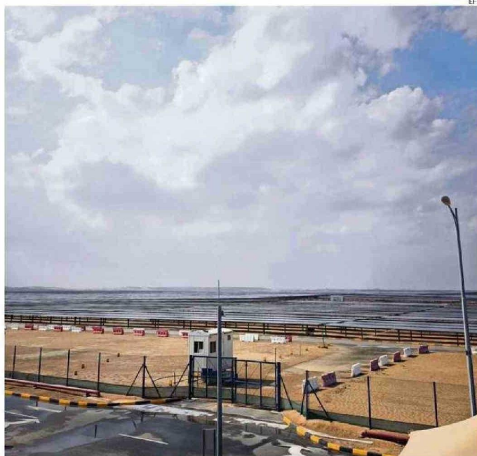
LA PLANTA FOTOVOLTAICA MÁS GRANDE DEL MUNDO YA SE ENCUENTRA EN ABU DABI.
