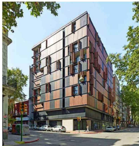
Edificio Alma Brava en Montevideo. 10 pisos de vivienda.
