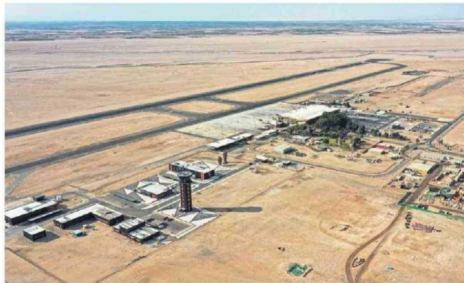
SE CONSTRUYERON UNA NUEVA TORRE DE CONTROL Y 5 PUNTES DE EMBARQUE, ENTRE OTRAS OBRAS.
