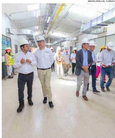
EL ALCALDE DE TEMUCO ENCABEZÓ LA INSPECCIÓN DE LAS OBRAS.
