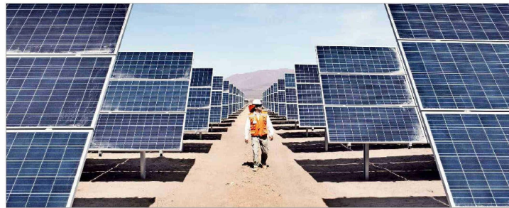
Representantes del sector de generación eléctrica subrayan la necesidad de tener reglas claras para operar las nuevas tecnologías de almacenamiento de energías renovables no convencionales, que son por naturaleza intermitentes.
