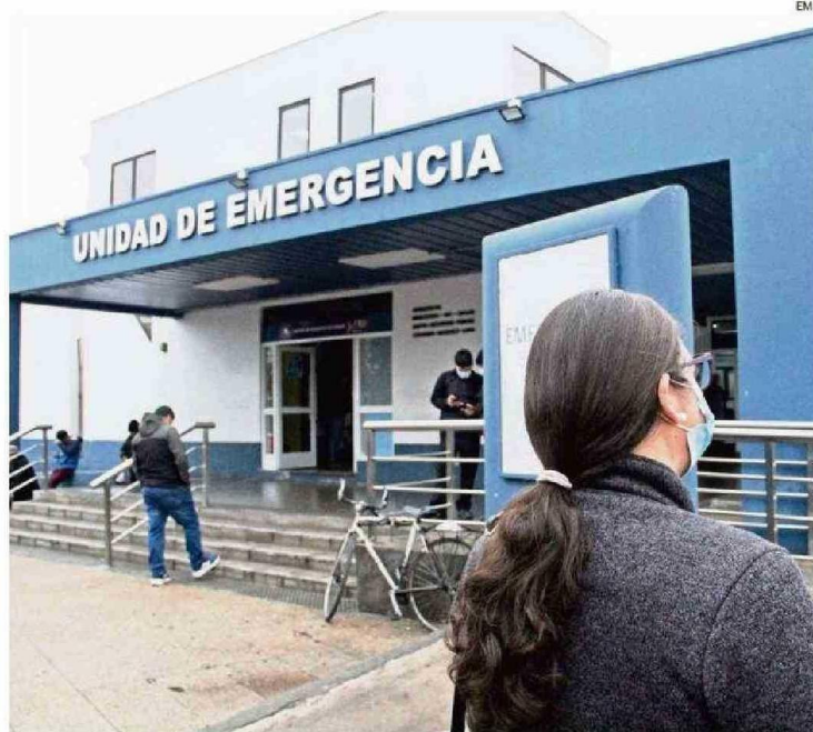
EMV LAS INVERSIÓN TAMBIÉN CONSIDERA LA SEGURIDAD INTERIOR Y EXTERIOR DEL RECINTO.
