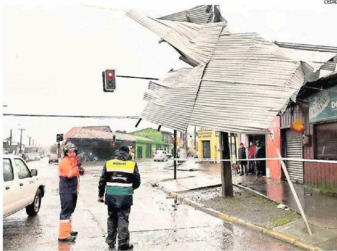
LA VOLADURA DE TECHUMBRES FUE LO QUE MÁS AFECTÓ AYER A LOS HABITANTES DE TALCAHUANO.
