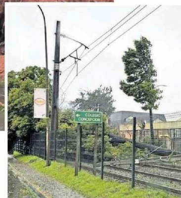
Durante este jueves los fuertes vientos causaron la caída de árboles y postes de electricidad en distintos puntos, afectando incluso el paso del Biotrén por la Línea 2.
