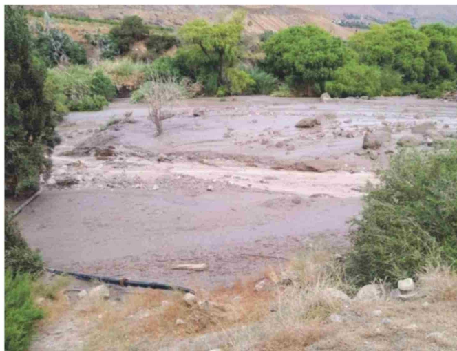
CEBIDA La activación de la quebrada La Viga provocó graves daños en el Sistema Sanitario Rural del lugar, dejando a 3.200 personas sin suministro de agua potable.
