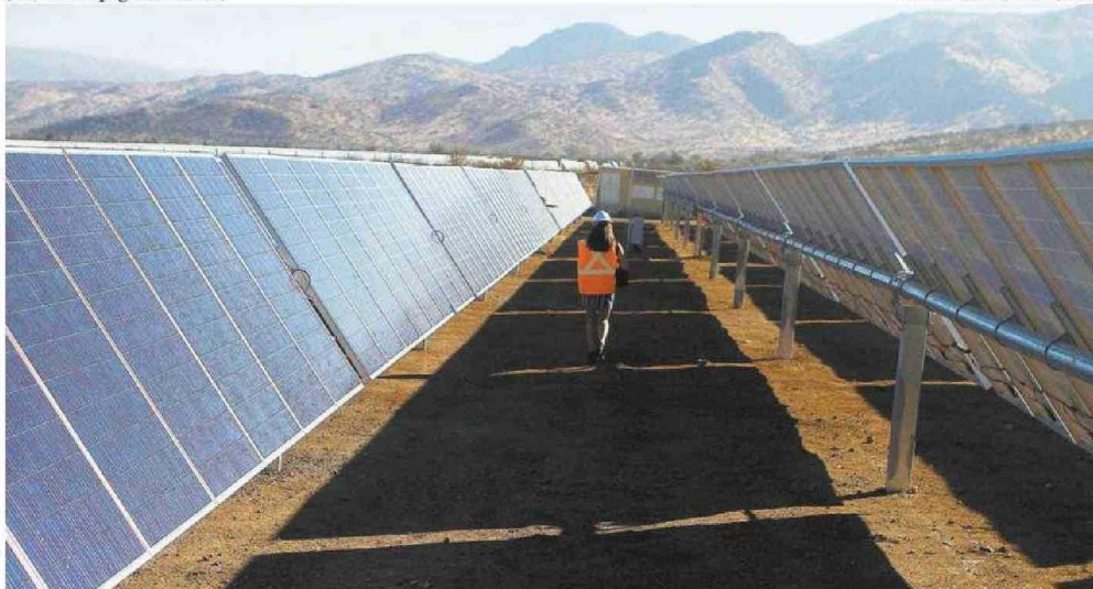
LA PRODUCCIÓN DE ENERGÍA AUMENTÓ EN LA REGIÓN, IMPULSADA POR NUEVAS PLANTAS ELÉCTRICAS Y DESACOPADA DE LA BAJA DEL PIB.
