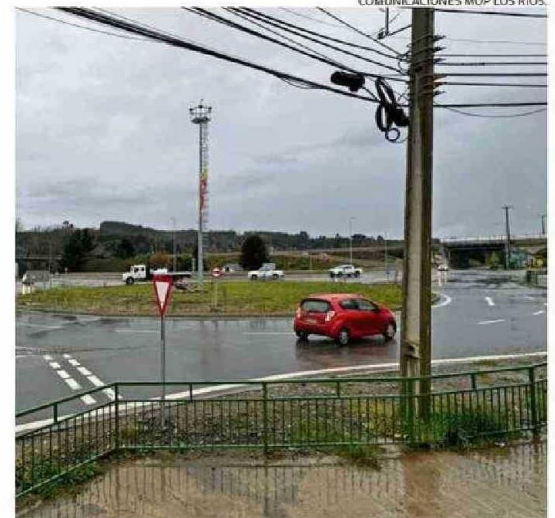
FALTA RESOLVER ALGUNOS TEMAS PENDIENTES ANTES DE LA RECEPCIÓN.
