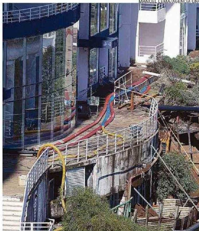
EN EL ÚLTIMO EPISODIO EL INMUEBLE SUFRIÓ DAÑOS.
