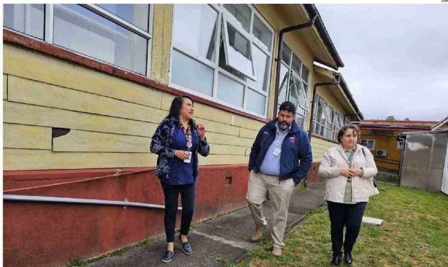
EL HOSPITAL COMUNITARIO DE ACHAO SE ENCUENTRA EN UNA ZONA SUSCEPTIBLE DE INUNDACIÓN POR TSUNAMI.
