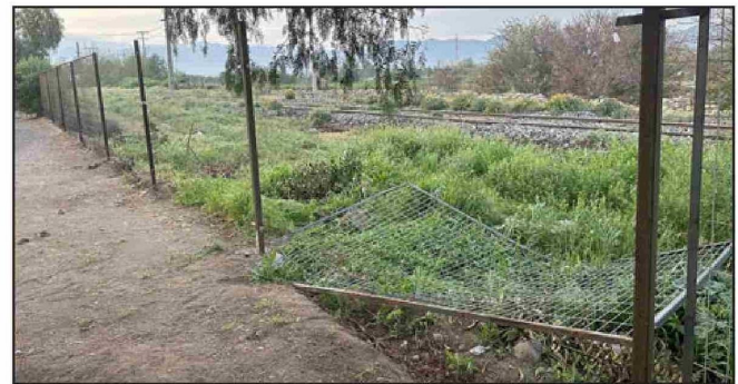
Paños sustraídos la madrugada de este sábado, junto al que no pudieron llevarse por estar adherido con cemento.
