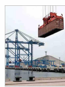
Durante la cumbre de APEC inauguraron el megapuerto de Chancay, construido con capitales chinos y con el que Perú intenta ser el principal centro logístico de la región. | B 6
