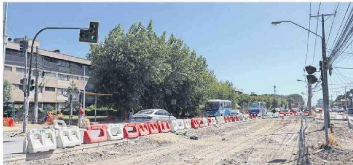
Los trabajos en el tramo 4A correspondiente a la comuna de Hualpén ya alcanzan un 50% de avance.
