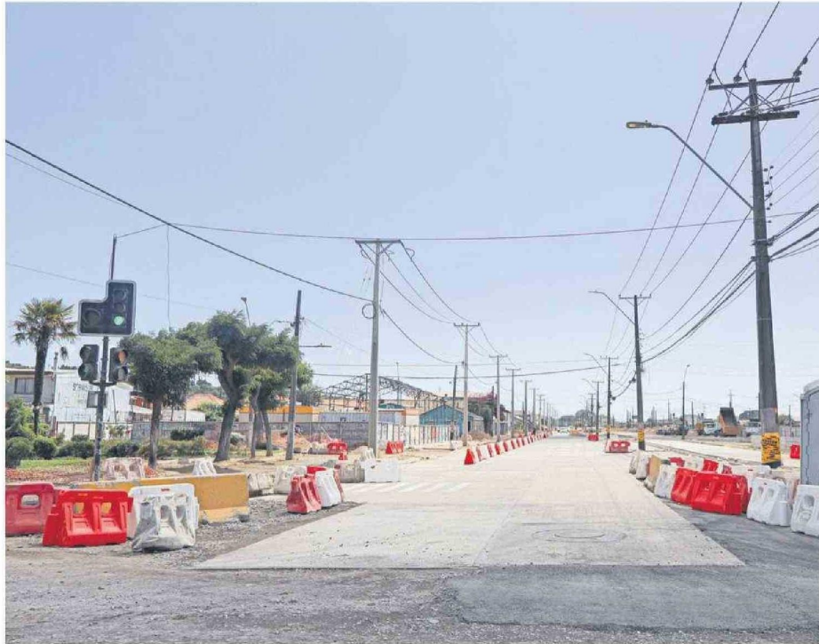
Un 34% de avance es el que registran las obras del tramo 3 del Eje Colón en Talcahuano, que se prevé su entrega para enero próximo.
