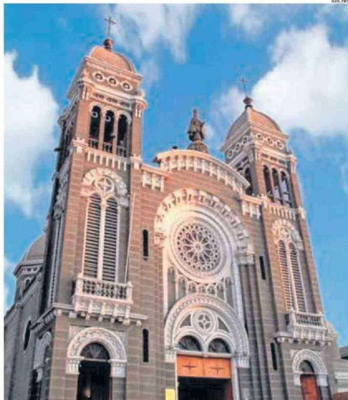
LAS OBRAS EN LA BASÍLICA SON UN EJEMPLO DE LOS INMUEBLES QUE DEBEN SER MEJORADOS.
