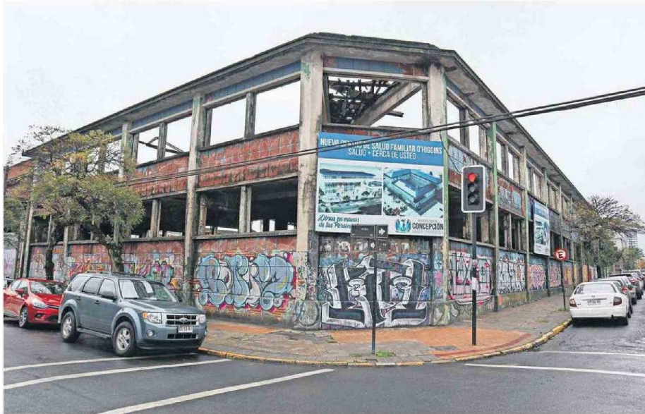
El proyecto se llevará a cabo en el terreno del ex Liceo Balmaceda de Concepción, entre las calles Las Heras y Salas.
