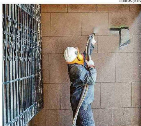
PROCESO DE LIMPIEZA SE REALIZA A TRAVÉS DE UN COMPRESOR.
