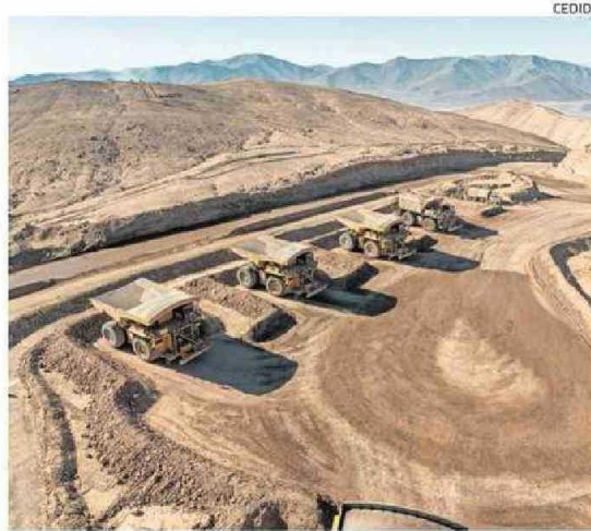
ACUERDO CONSIDERA CONSTRUIR UNA NUEVA PLANTA DE TRATAMIENTO. CEDIDA
