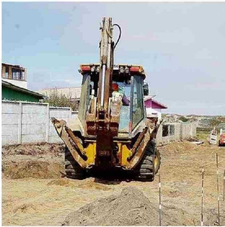
LOS TRABAJOS SE EJECUTAN EN DISTINTOS FRENTES.
