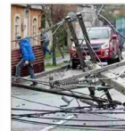
Un tornado voló techos y derribó árboles y postes en Penon.
