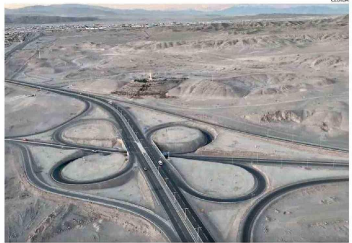
OBRAS ALCANZAN EL 60 POR CIENTO Y LA INSTALACIÓN DE 200 POSTES.
