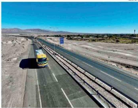
CADA LUMINARIA TIENE UNA POTENCIA DE 225 WATTS.
