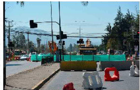
Trabajos en cruce Av. Bombero Villalobos con la Carretera El Cobre
