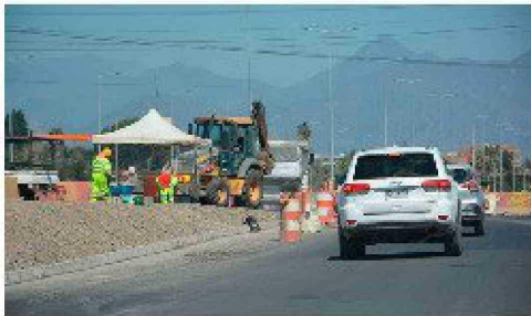
Trabajos en Carretera El Cobre cruce camino Santa Emilia
