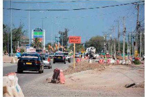
Desvíos y trabajos a las afueras del Hospital Clínico Fusat.
