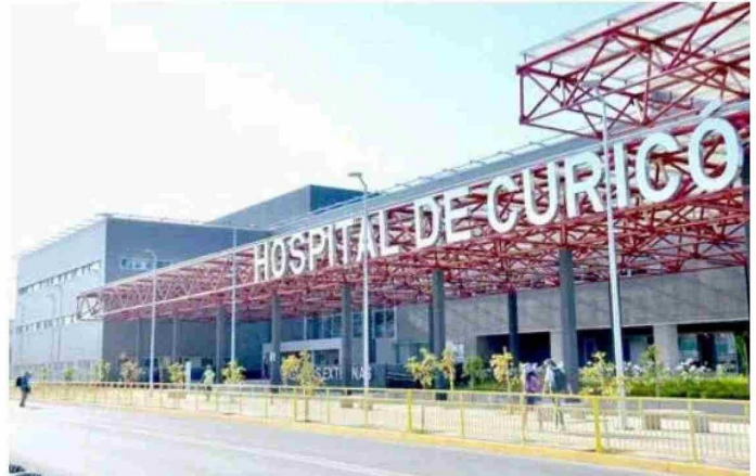
Preocupante situación se vivió en el moderno recinto asistencial.
