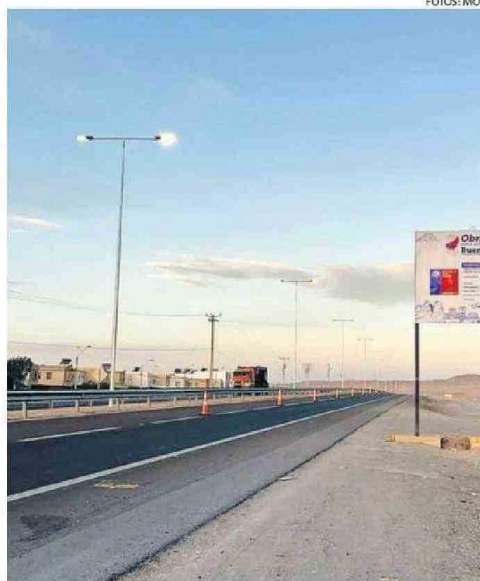
PROYECTO CUMPLE CON LA NUEVA NORMATIVA PARA PREVENIR LA “CONTAMINACIÓN LUMÍNICA”.
