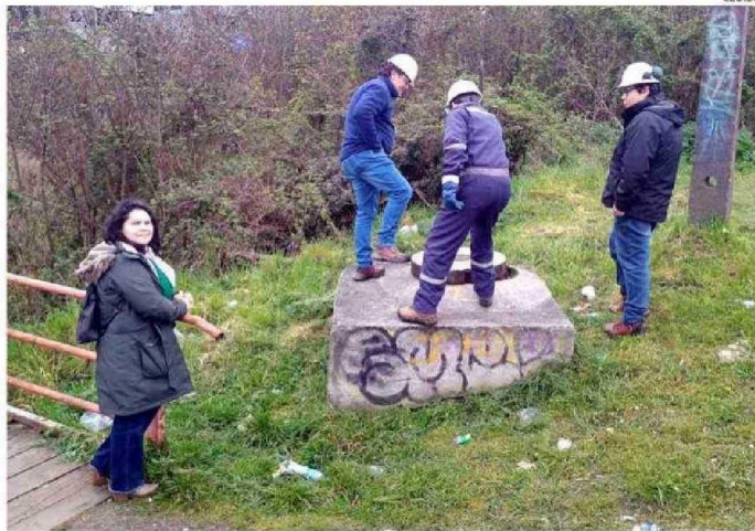
ESTE VIERNES SURALIS ESTUVO INSPECCIONANDO OTRA DE LAS CÁMARAS CERCANAS AL RÍO DAMAS.
