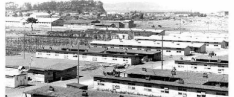
Una de las empresas relevantes en la historia de Talcahuano es la siderúrgica Huachipato. En la imagen se muestra una vista de las antiguas instalaciones.
