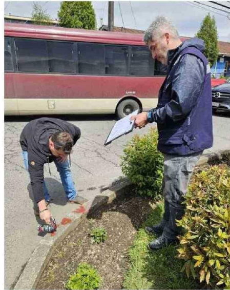
MARCACIÓN VIAL PARA SEMÁFORO EN CHONCHI.
