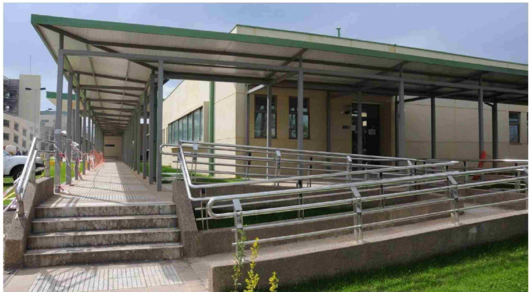
SEGÚN DETALLÓ ALVIAL, se están afinando algunos detalles antes de la recepción de las obras realizadas al edificio.
