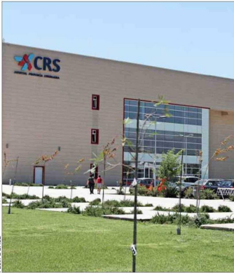
RECINTO.— El Hospital Provincia Cordillera se ubica en la comuna de Puente Alto.
