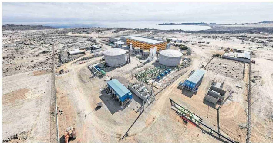
LA PLANTA DESALINIZADORA DE AGUAS CAP ES UNA DE LAS PRIMERAS EN EL PAÍS EN SER MULTIPROPÓSITO
