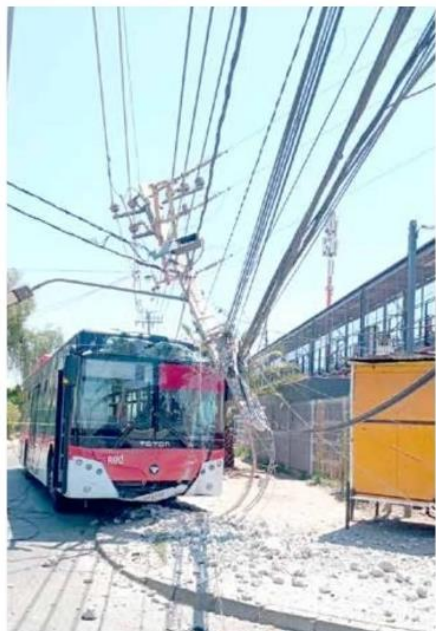
Hay vecinos de la Región del Maule que han debido soportar hasta 12 horas sin luz para la reparación de un poste chocado.
