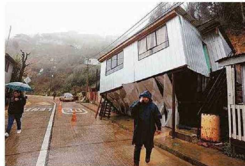
EN EL CERRO SAN ROQUE COLAPSÓ UN INMUEBLE DEBIDO A LAS LLUVIAS.
