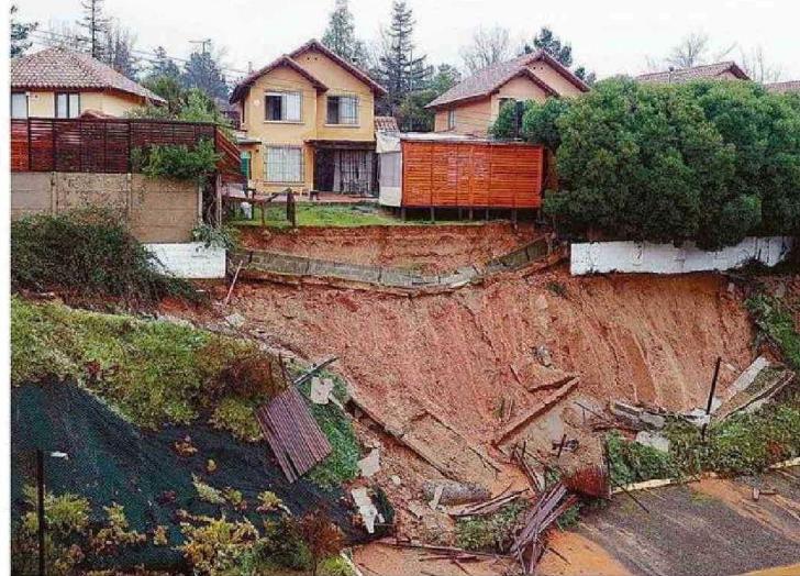
LAS LLUVIAS PROVOCARON EL DESLIZAMIENTO DE TIERRA EN UN CONDOMINIO EN EL SECTOR DE CURAUMA.
