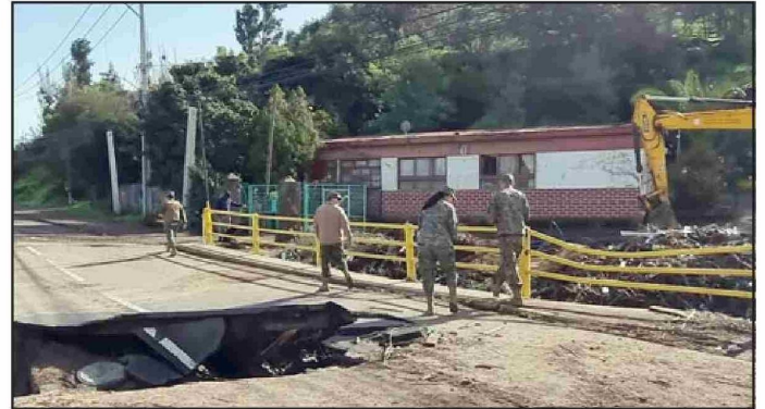
Ejército de Chile comenzó las labores de instalación del puente mecano en Llay Llay.
