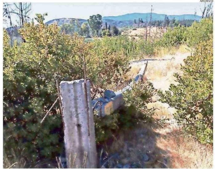
DESCONOCIDOS ROBARON CASI 6 MIL METROS DE CABLE EN MEDIO DEL TOQUE DE QUEDA POR CORTE DE LUZ.
