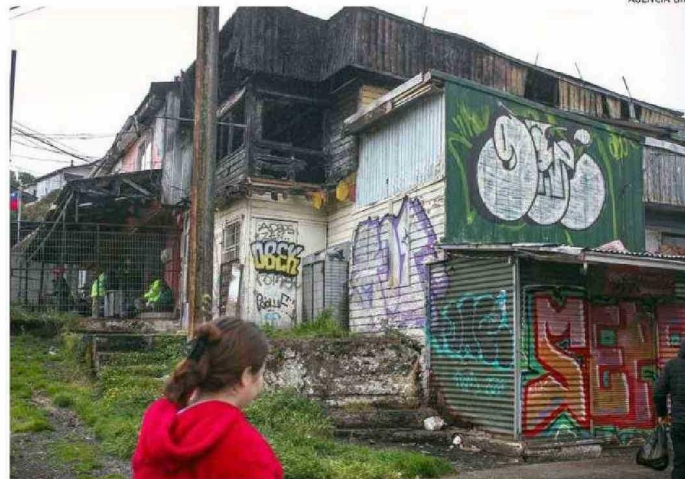
LA FALTA DE CIERRES PERIMETRALES O DE MANTENCIÓN EVIDENCIAN EL ABANDONO DE ESTAS PROPIEDADES.
