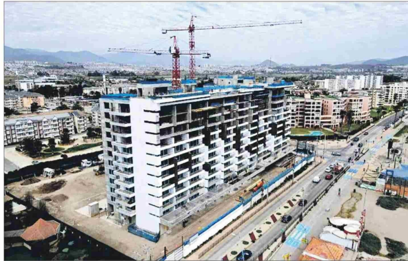
La azotea, en el piso 13, se considera zona de seguridad ante un tsunami, con espacio para hasta 400 personas.
