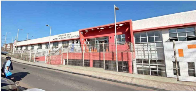
RESGUARDOS.— Rejas perimetrales cada vez más reforzadas tienen algunos centros de atención primaria de salud en Arica. Hay rondas policiales en la noche, pero en general la iluminación en calles adyacentes es deficiente.
