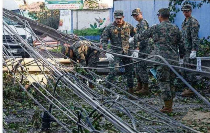
PERSONAL DEL EJÉRCITO SE UNIÓ AYER A LOS TRABAJOS DE LOS MUNICIPIOS Y LAS EMPRESAS PARA RESTABLECER LA RED ELÉCTRICA.
