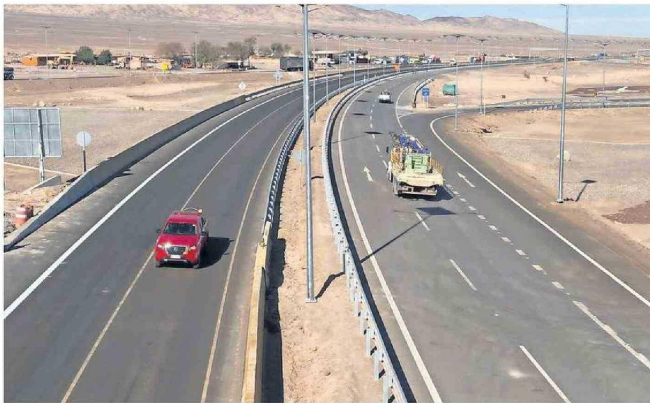
ADEMÁS REALIZARÁN MEJORAMIENTO Y CONSTRUCCIÓN DE DISTINTAS INICIATIVAS A LO LARGO DE LA OBRA.
