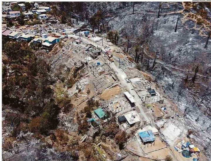
CONSTRUCCIÓN EN QUEBRADAS EN LA INTERFASE URBANA ES UNO DE LOS PRINCIPALES RIESGOS DE INCENDIOS.
